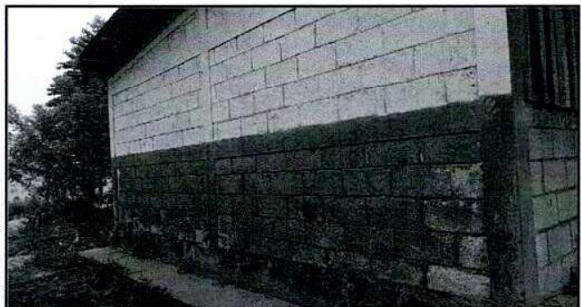
Foto 6: Pintura en muros exteriores e interiores
