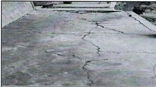
Foto 3: Sustrucción de piso de torta de concreto
