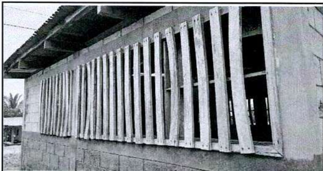
Foto 5: Sustrucción de balcones de madera por metal
