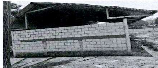
Foto 4: Elevacion de mojinete con block.
