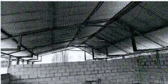
Foto 5: colocacion de solera
