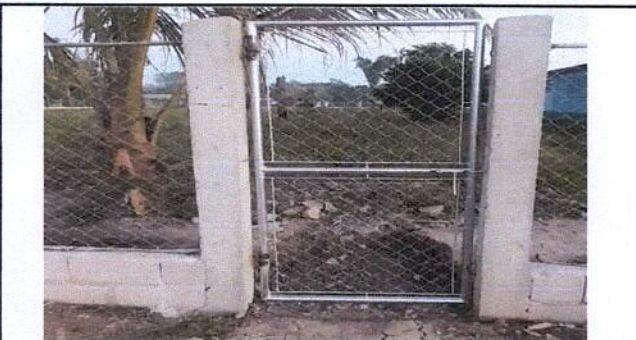
Foto 5: sustitucion de base del porton.
