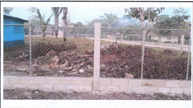
Foto 2: sustitucion de malla.
