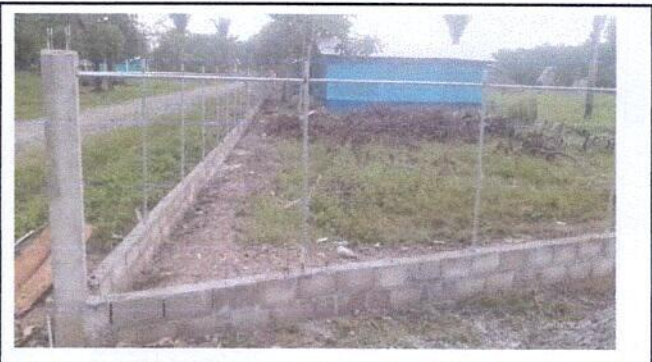
Foto 4: sustitucion de horcones
