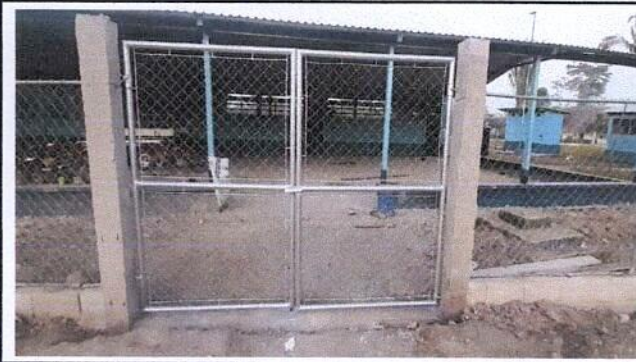
Foto 3: sustitucion de porton.
