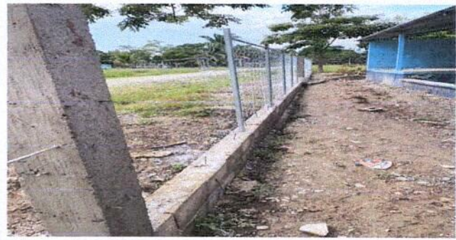
Foto 2: sustitucion de malla.
