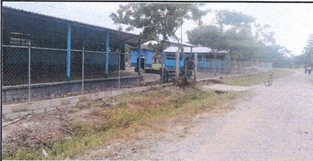
Foto 5: sustitucion de base del porton.
