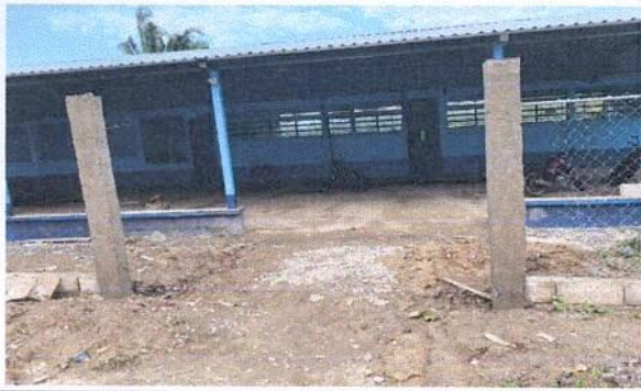
Foto 3: sustitucion de porton.
