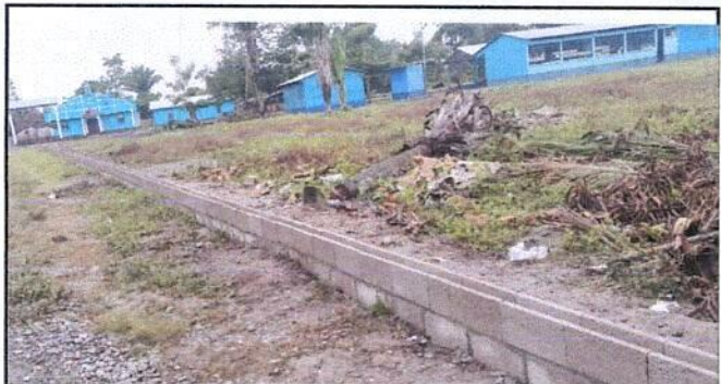
Foto 6: sustitucion de block.
