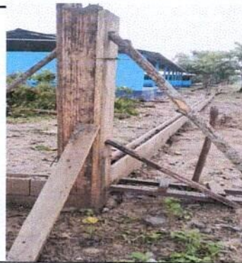
Foto 4: sustitucion de horcones
