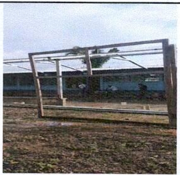
Foto 3: sustitucion de porton.
