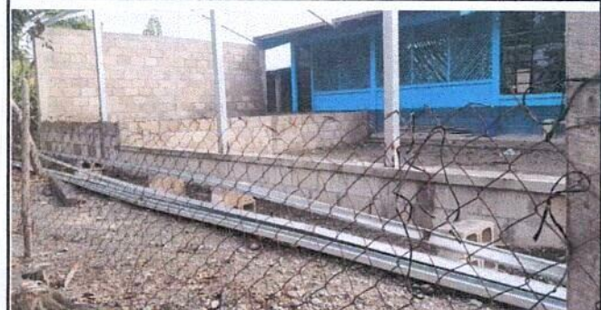
Foto 2: sustitucion de malla.
