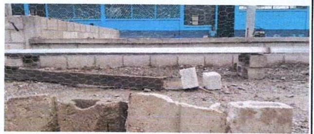
Foto 6: sustitucion de block.
