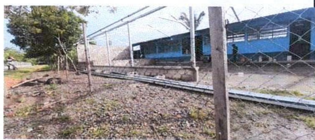
Foto 4: sustitucion de horcones
