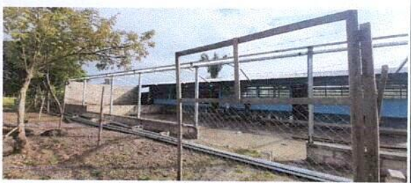
Foto 5: sustitucion de base del porton.
