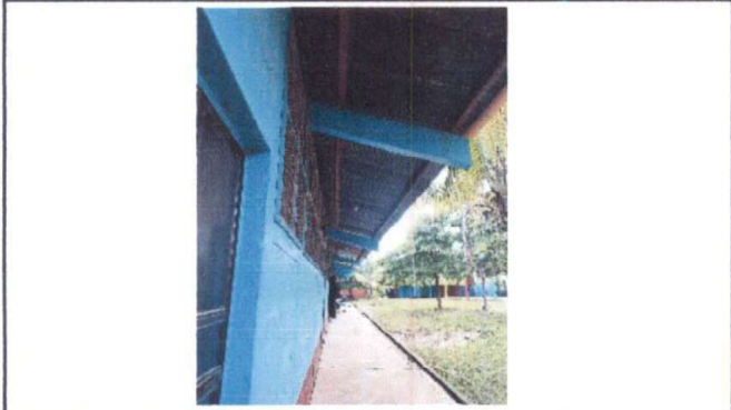
Foto 7 modulo 1: colocacion de tablayeso en solera
