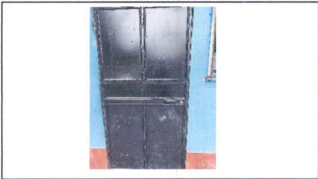
Foto 11 modulo 1: mantenimiento de puerta
