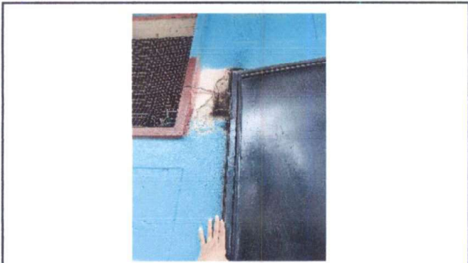
Foto 9 modulo 1: mantenimiento de puerta
