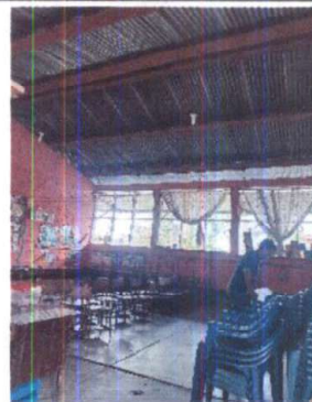
Foto 4 modulo 1: cambio de lamina
