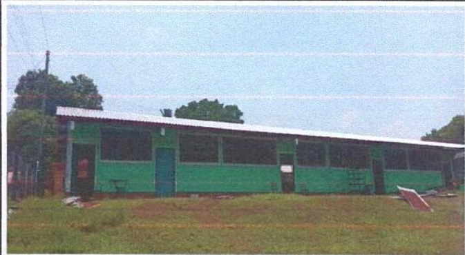
Foto 1: Sustitución de lámina del techo del edificio escolar
