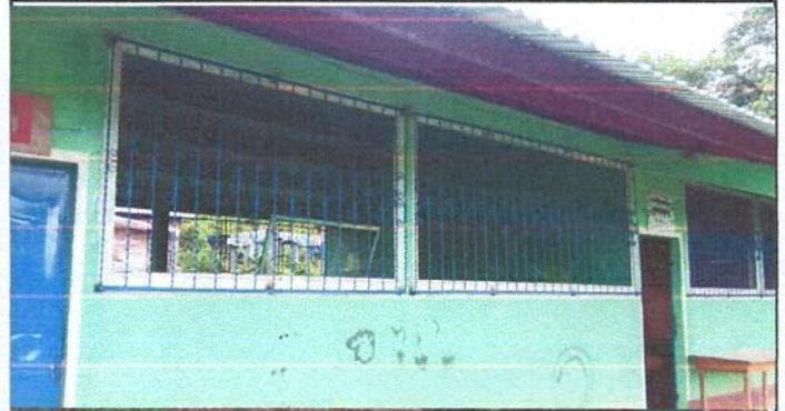
Foto 2: Mantenimiento a estructura de soporte de metal
