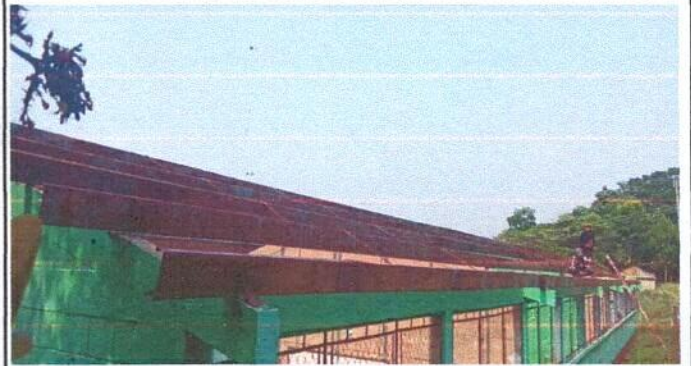
Foto 2: Mantenimiento a estructuras de soporte de metal
