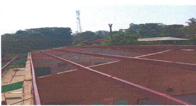
Foto 1: Sustitución de lamina del techo del edificio escolar
