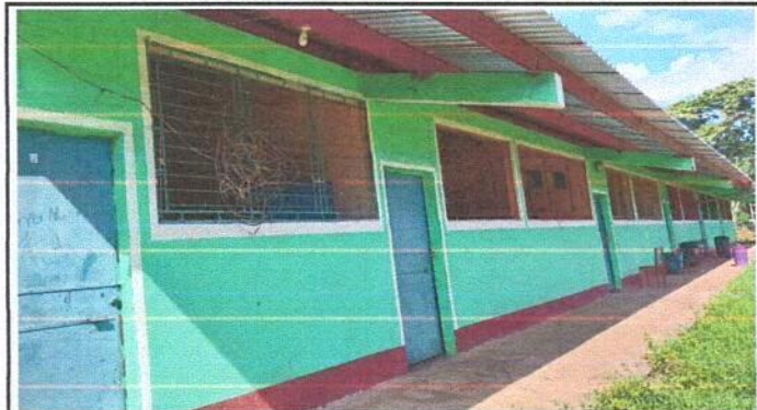
Foto 4 : Sustitución de elementos de fijación
