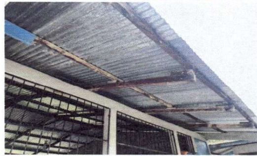
Foto 4: PARTE DE LA ESTRUCTURA DEL TECHO, COMPLEMENTADA CON COSTANERAS DE MADERA.
