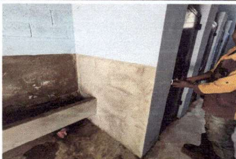
Foto 10: SANITARIOS DE ESCUELA EN CONDICIONES ACEPTABLES.
