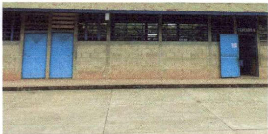
Foto 9: VISTA EXTERIOR DE OTRO MODULO DE AULAS EN CONDICIONES ACEPTABLES.
