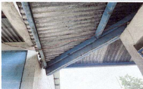
Foto 8: ESTRUCTURA DEL TECHO DE LOS MODULOS DE METAL REFORZADAS.
