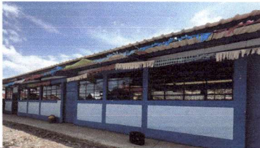
Foto 3: OTRO MODULO DE AULAS EN BUENAS CONDICIONES.
