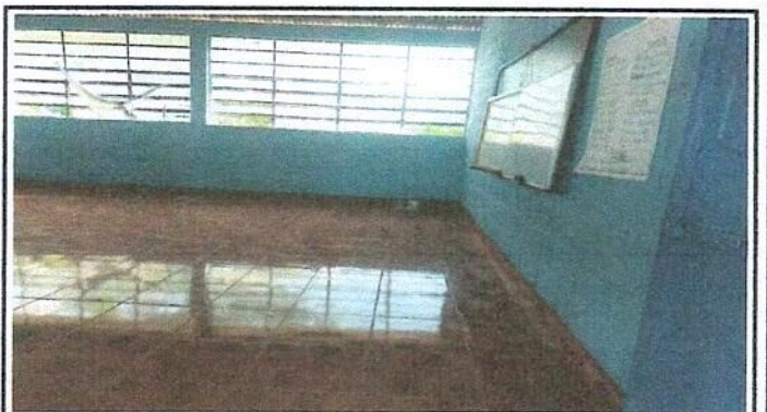
Foto 4: Sustitución de piso de torta por piso cerámico, Fanalizado.
