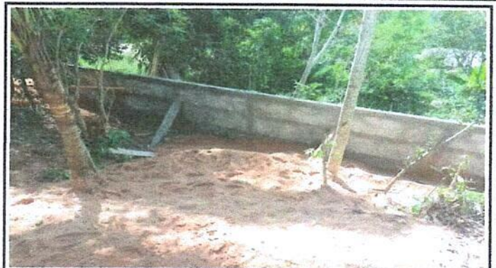
Foto 2: Muro de contención, Levantado de muro con block, soleras, intermedias y columnas. Finalizado.
