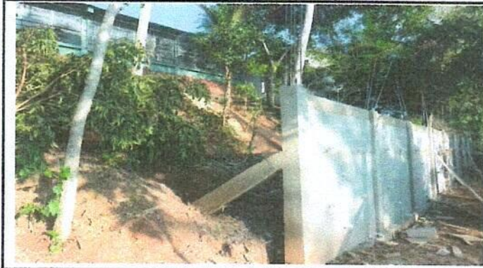
Foto1: Muro de contención, Levantado de muro con block, soleras, intermedias y columnas. Finalizado.
