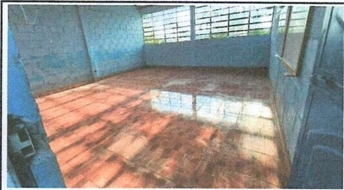
Foto 3: Sustitución de piso de torta por piso cerámico, Fanalizado.
