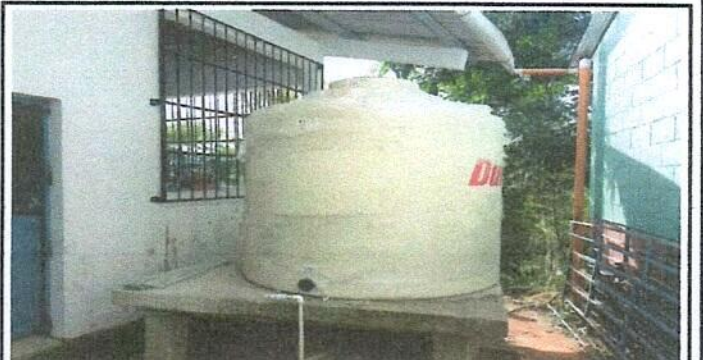
Foto 6: Sustitución de deposito de agua. Fanalizado.
