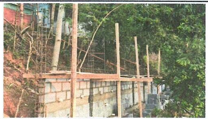
Foto 2: Muro de contención, Levantado de muro con block de arena, soleras intermediaas y columnas.
