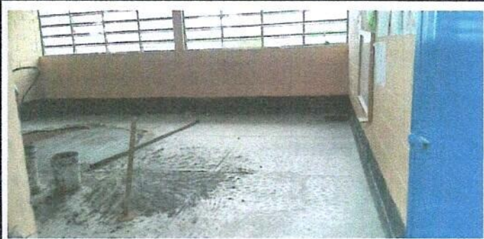
Foto 3: Sustitucion de piso de torta por piso cerámico.
