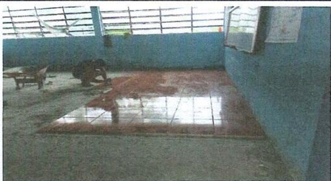
Foto 4: Sustitucion de piso de torta por piso cerámico.
