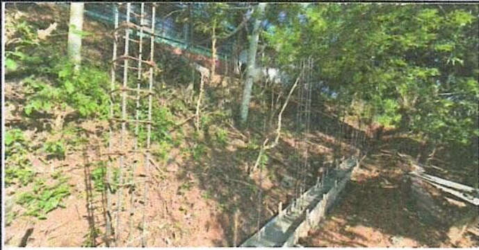
Foto1: Muro de contención, Levantado de muro con block de arena, soleras intermediaas y columnas.
