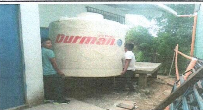
Foto 6: Sustitución de depósito de agua.
