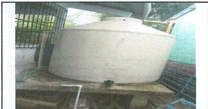
Foto 5: Sustitución de depósito de agua.
