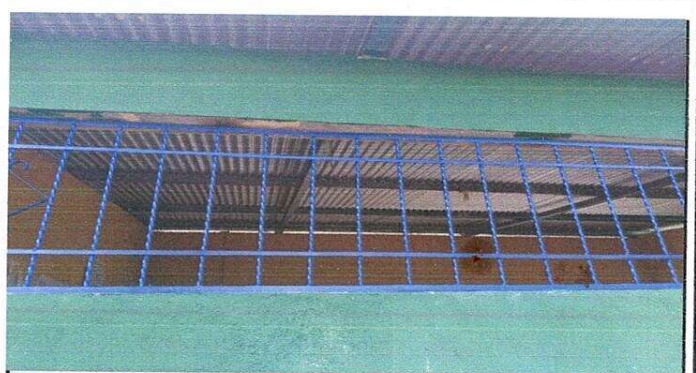
Foto 6: sustitucion de balcones
