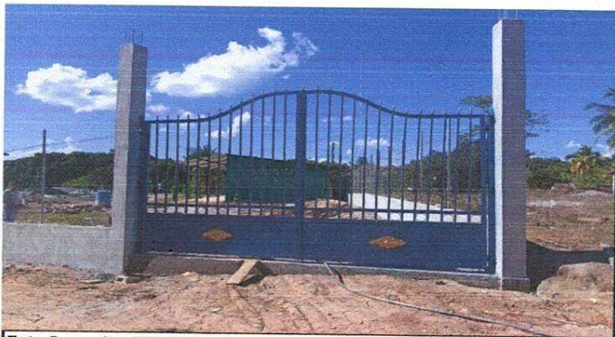
Foto 5: sustitucion de portón
