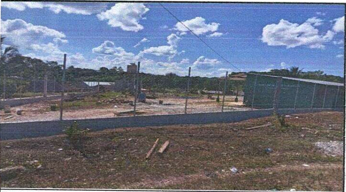
Foto 3: Sustitución de malla por malla galvanizada.
