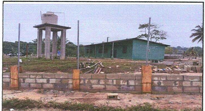
Foto 2: Sustitucion de horcón por tubo Hg
