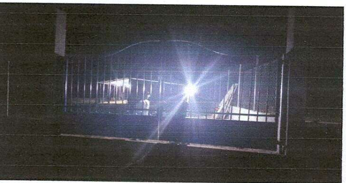
Foto 5: sustitucion de portón
