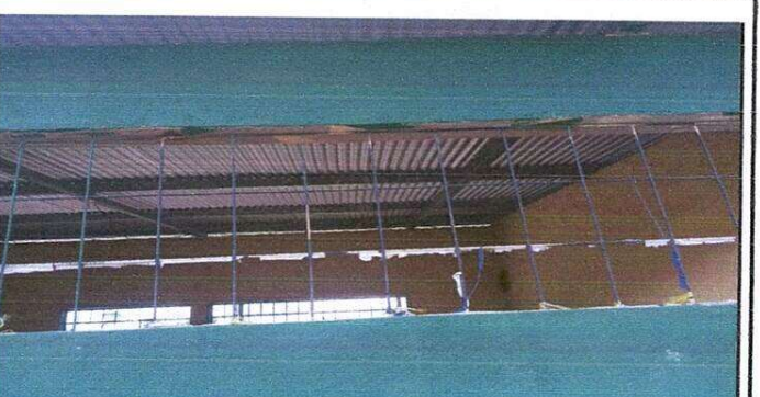
Foto 6: sustitucion de balcones
