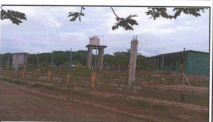
Foto 4: sustitucion de Horcón por columnas
