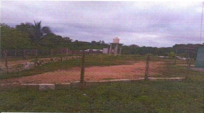
Foto 3: Sustitución de malla por malla galvanizada.
