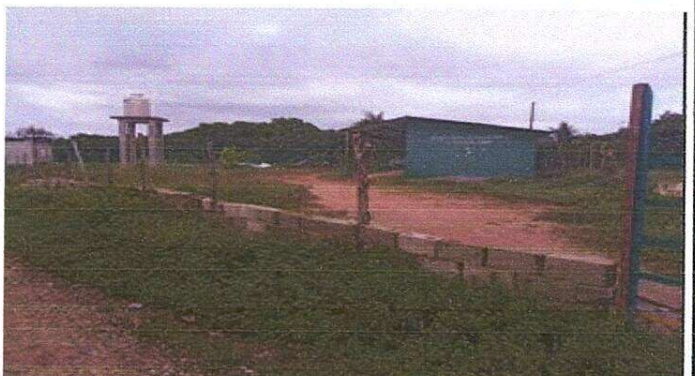
Foto 4: sustitucion de Horcón por columnas
