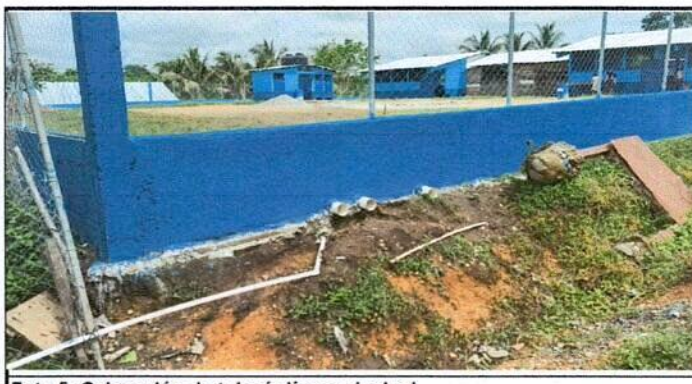
Foto 5: Colocación de tubería línea principal
