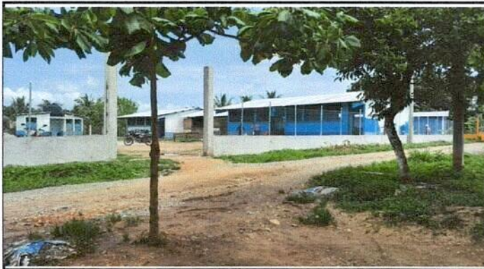
Foto 1: Vista frontal sin pintura
