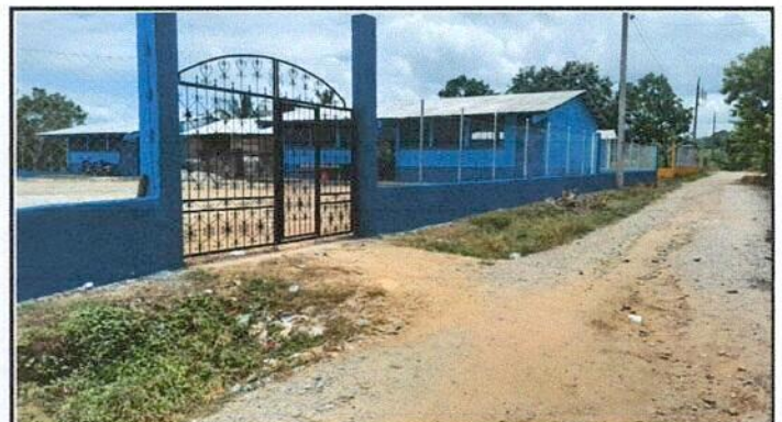
Foto 4: Sustitución de Portón de madera a metal
