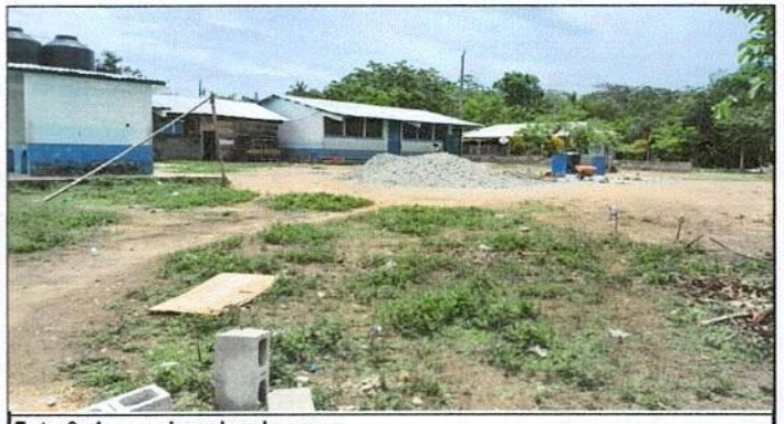
Foto 6: 4 camionadas de arena
