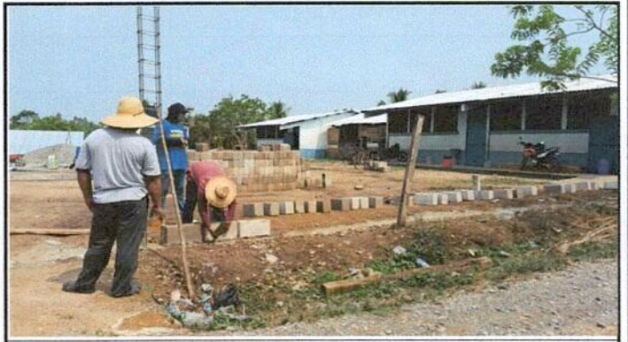
Foto 2: Colocación de primer block
