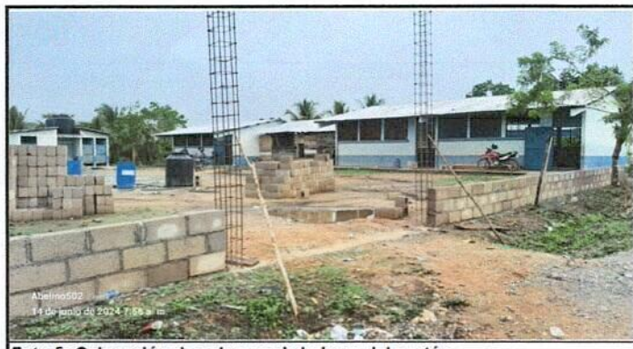
Foto 5: Colocación de columna de la base del portón
