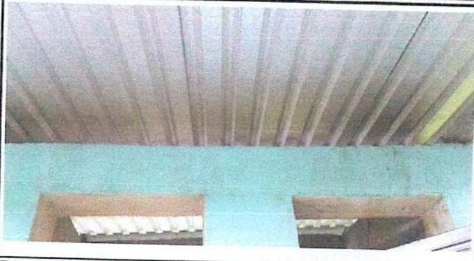
Foto 1: Sustitución de lamina, por lamina troquelada aluzin calibre 26 del servicio sanitario
