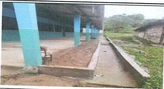
foto: 5 Reparacion de cuneta de concreto de EORM
