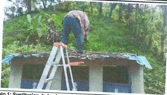
Foto 1: Sustitucion de lamina, por lamina troquelada aluzin calibre 26 del servicio sanitario
