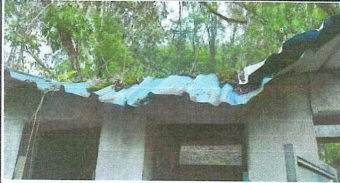
Foto 1: Sustrucion de lamina, por lamina troquelada aluzin calibre 26 del servicio sanitario
