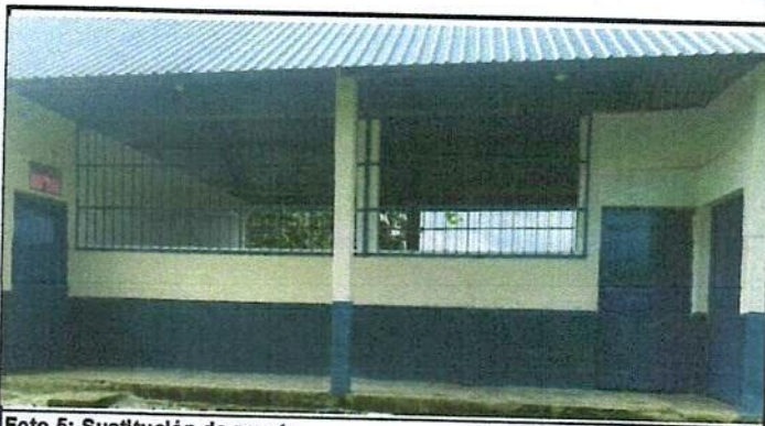
Foto 5: Sustitución de puerta
