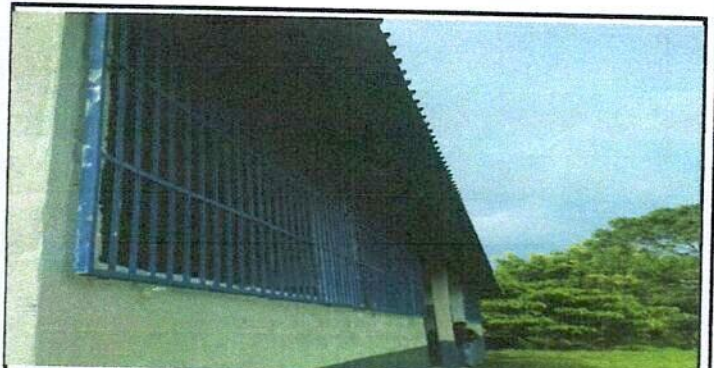
Foto 6: Sustitución de ventanas de malla por balcones de metal
