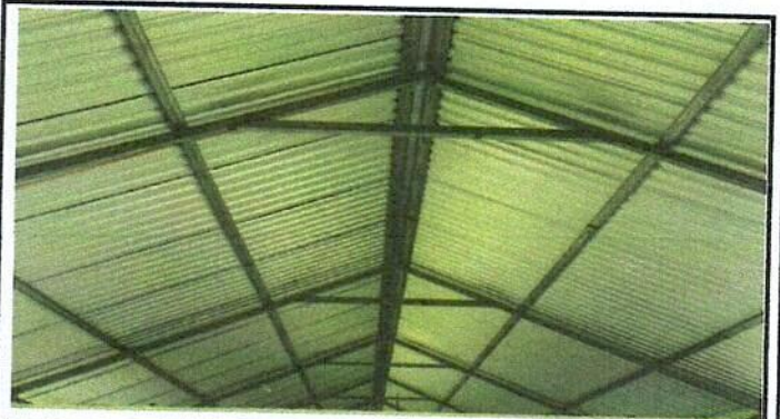
Foto 4: Sustitución de estructura de soporte de madera por metal
