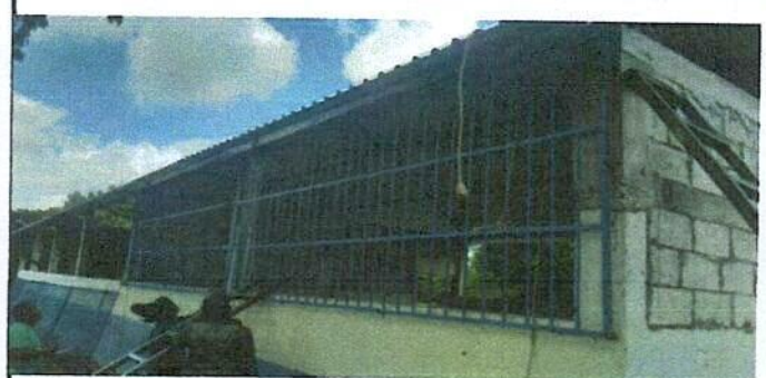
Foto 6: Sustitucion de ventanas de malla por balcones de metal
