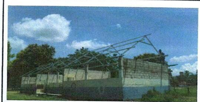
Fotoco 4: Sustitución de estructura de soporte de madera por metal
