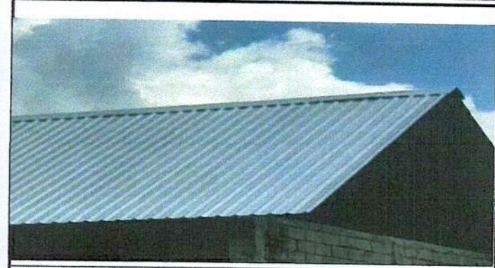
Foto 2: Sustitución de capote de lamina por lamina troquelada
