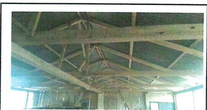
Foto 4: Sustrucion de estructura de soporte de madera por metal
