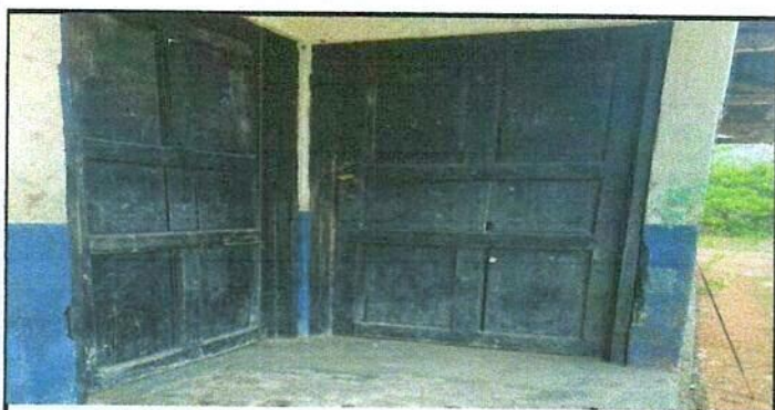
Foto 5: Sustrucion de puerta
