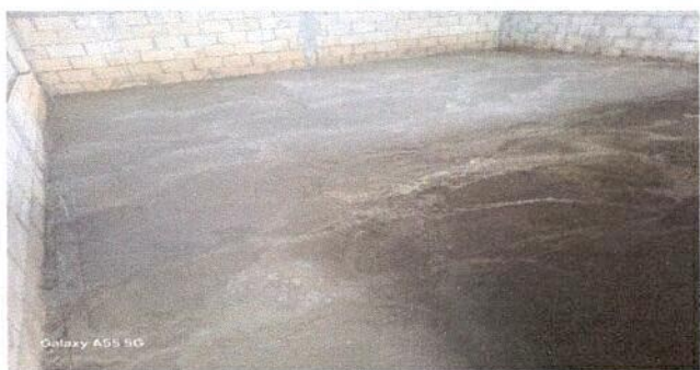
Foto 4: FINALIZACION DE PISOS DE 2 AULAS
