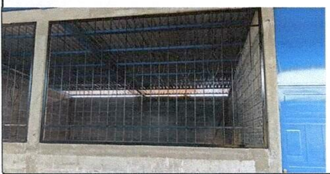
Foto 5: FINALIZACION DE VALCONES
