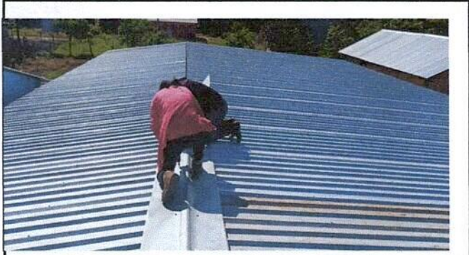
Foto1: ESTRUCTURA YA INSTALADA
