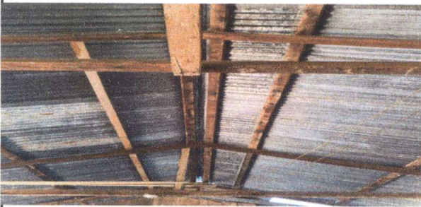
Foto 3: sustitucion de estructura de soporte de madera por metal
