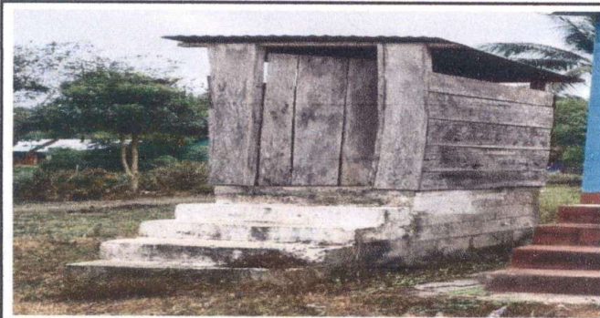
Foto 4: Sustitucion de puertas en servicio de sanitarios
