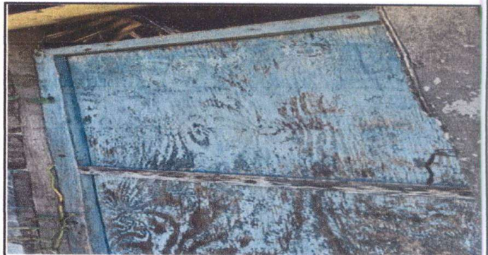
Foto: sustitucion de puerta
