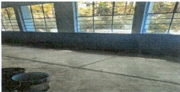
Foto 5: en algunas partes se echo la torta de cemento en las aulas.
