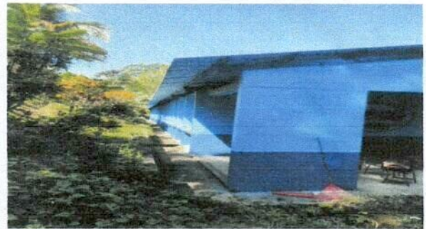
Foto 4: se pinto toda la parte de atrás de la escuela
