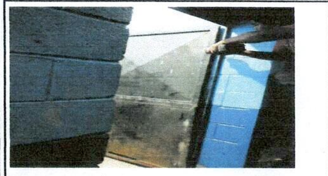
Foto 3: se esta trabajando el cambio de la puerta bodega 1 y 2
