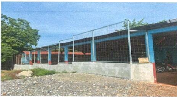
Foto 5: Muro perimetral finalizado
