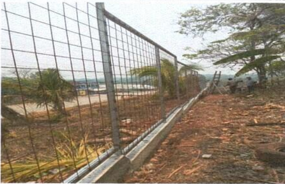
Foto 3: Muro perimetral con maya
