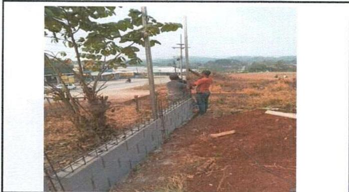
Foto 3: Muro perimetral sin tubos galvanizados
