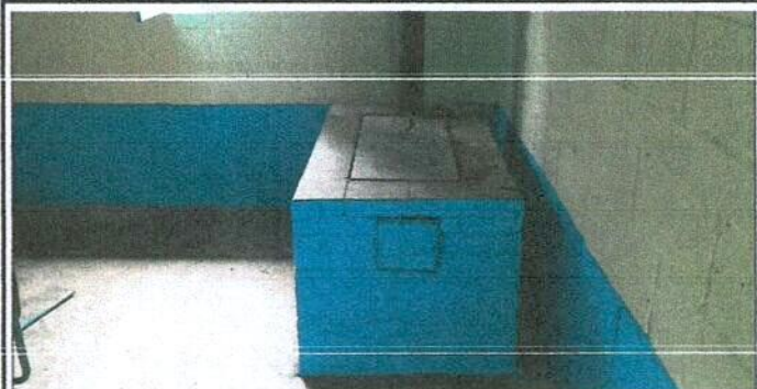
Foto 6: Sustitucion de plancha de metal de 3 hornillas
