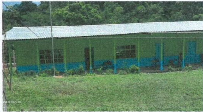
Foto1: Sustitucion de lámina, por lamina troquelada aluzinc calibre 26
