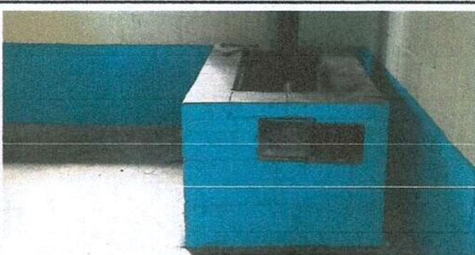
Foto 6: Sustitucion de plancha de metal de 3 hornillas
