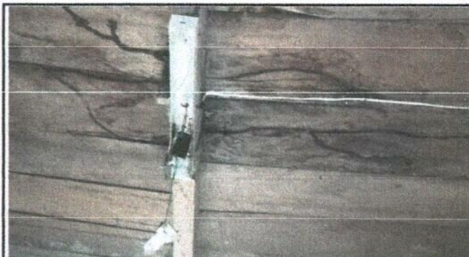
Foto 4: Reparacion de sistema electrico
