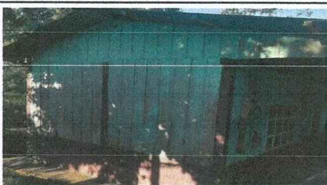
Foto 3: Pintura en muros exteriores e interiores
