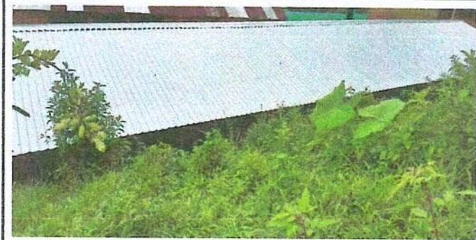
Foto1: Sustitucion de laminas por láminas troqueladas cal.26
