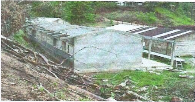
Foto1: Sustitucion de laminas por láminas troqueladas cal.26
