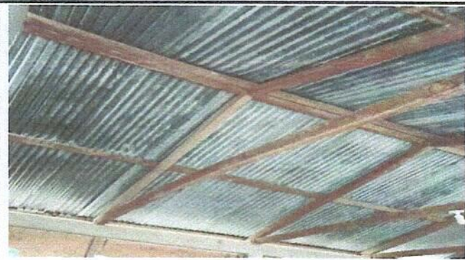
Foto 3: Sustitucion de estructura de soporte de madera a metal
