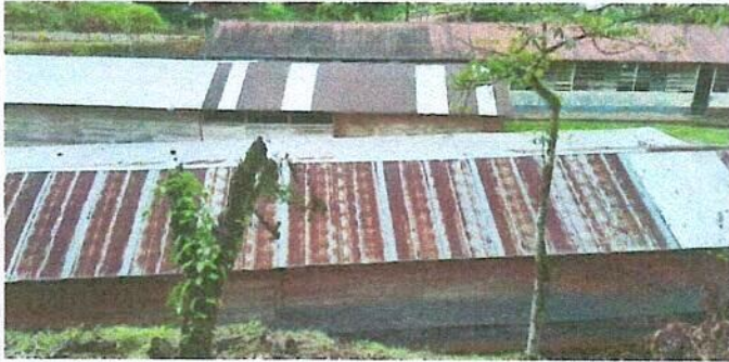
Foto: 1 Sustitucion de laminas por laminas troqueladas alizinc cal 26.
