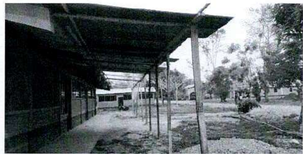
Foto 4: sustitucion de costaneras
