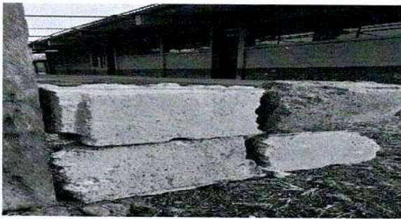
Foto 3: sustitucion de block.
