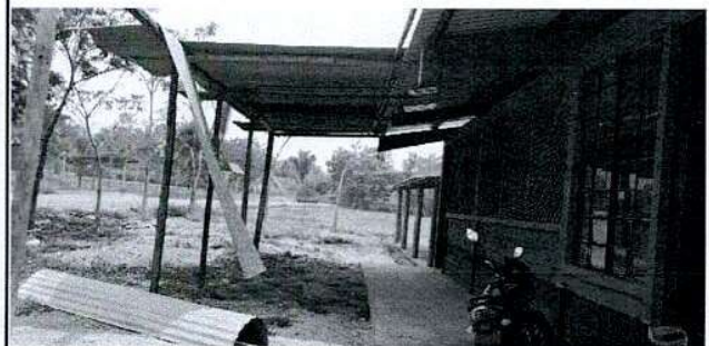
Foto 6: sustitucion de láminas.
