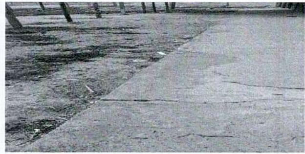
Foto 2: sustitucion de torta de cemento.
