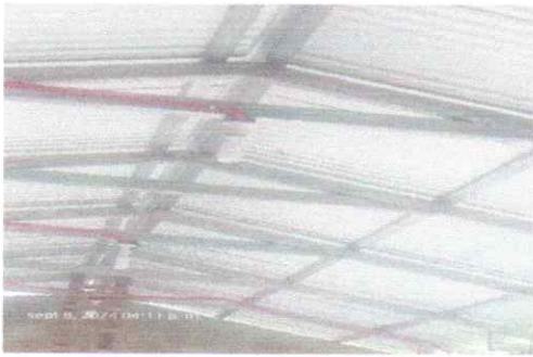
Foto 3: Sustitucion de vigas
