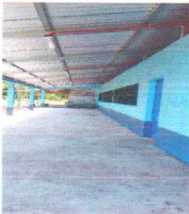
Foto 4: sustitución de costaneras
