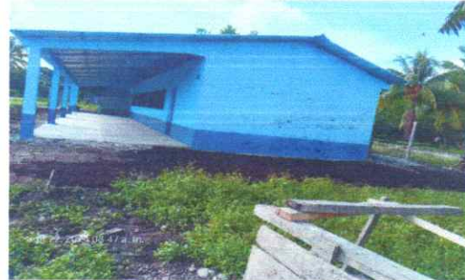
Foto 6: sustitucion de fijación.
