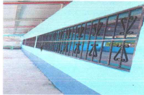
Foto 4: Sustitucion de torta de concreto
