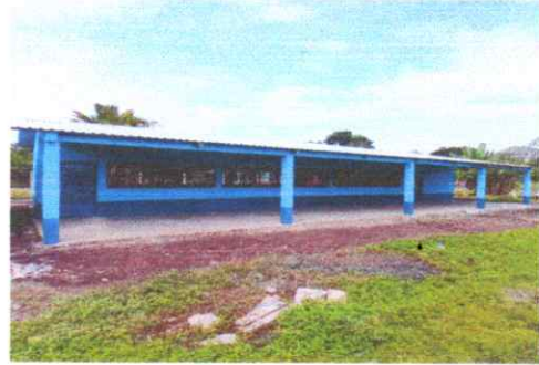
Foto2: sustitución de Láminas
