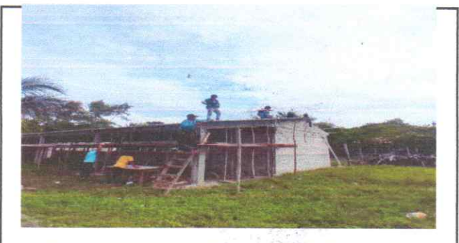
Foto 6: sustitucion de fijación.
