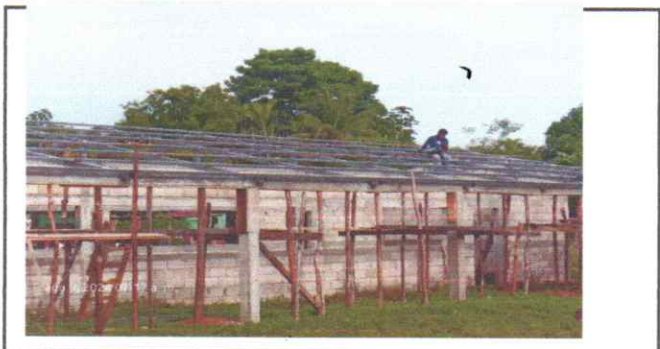
Foto 4: sustitución de costaneras
