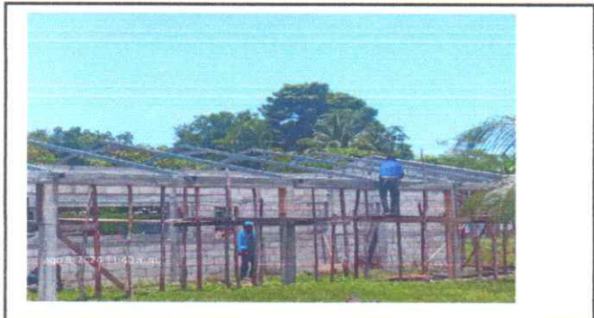
Foto 3: Sustitucion de vigas
