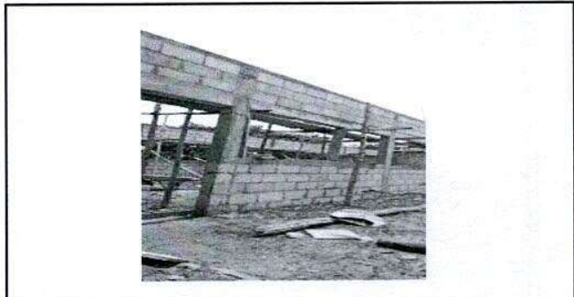
Foto 6: sustitucion de fijación.
