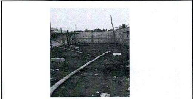
Foto 4: Sustitucion de torta de concreto
