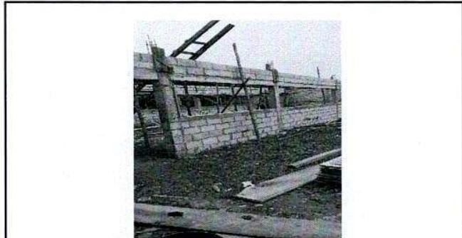
Foto 3: Sustitucion de vigas
