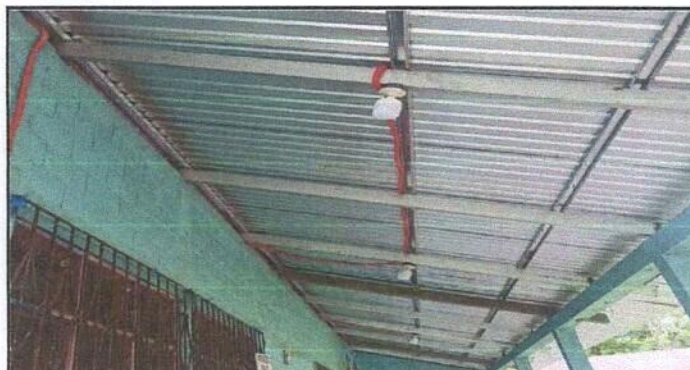
Foto 3: Sustitución de la estructura de madera por metal del módulo 1.
