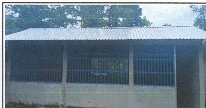
Foto 5: Sustitución de capote para lámina troquelada del módulo 2.
