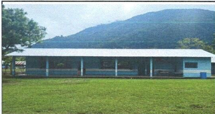
Foto 1: Sustitución de la cubierta de lámina por lámina troquelada del módulo 1.
