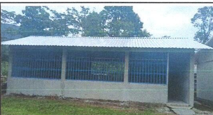
Foto 4: Sustitución de la cubierta de lámina por lámina troquelada del módulo 2.
