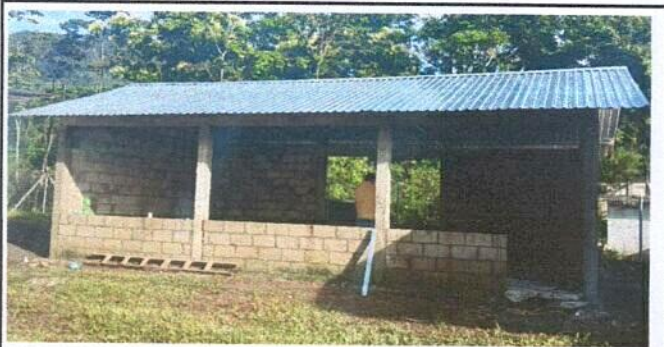
Foto 5: Sustitución de capotes para lámina troquelada del módulo 2.
