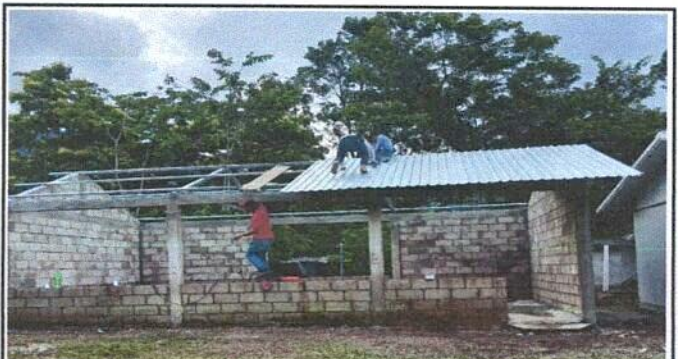
Foto 4: Sustitución de la cubierta de lámina por lámina troquelada del módulo 2.
