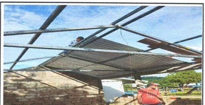
Foto 6: Sustitución de estructura de madera por metal del módulo 2.
