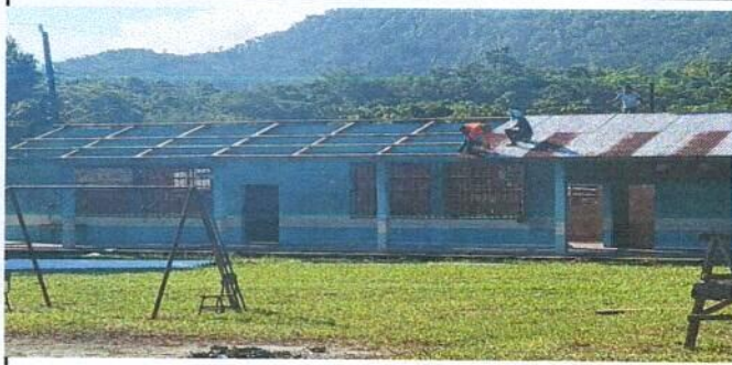
Foto 1: Sustitución de la cubierta de lámina por lámina troquelada del módulo 1.
