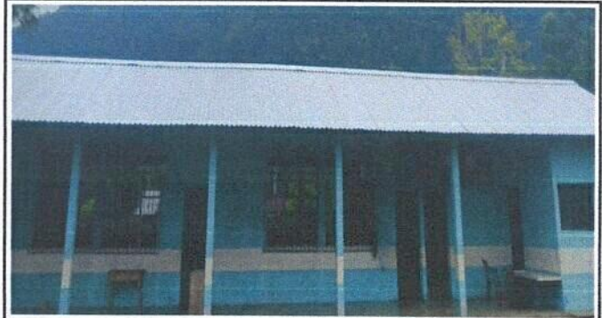
Foto 2: Sustitución de capote para lámina troquelada del módulo 1.
