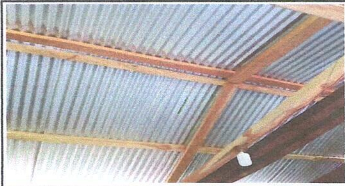
Foto 1: Sustitución de techo de la cocina
