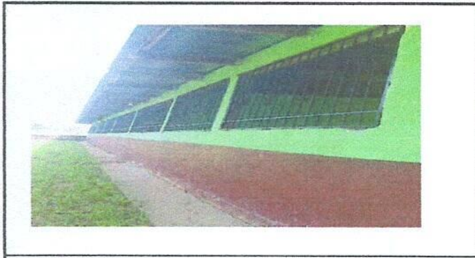
Foto 5: Sustitución de ventanas de madera por balcones de metal.
