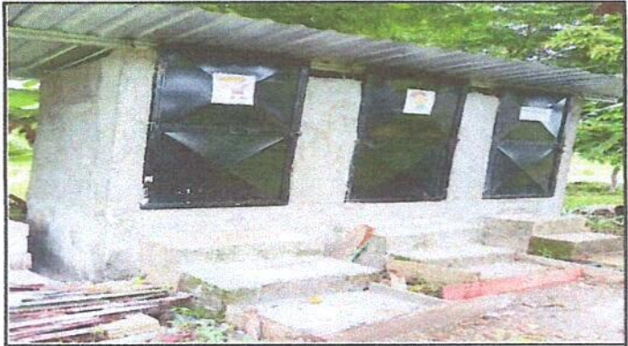
Foto 2: Sustitución de pared de madera por block.
