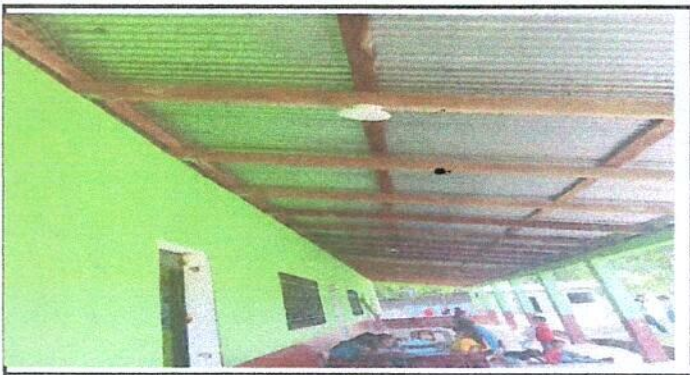
Foto 6: Sustitución de focos y plafoneras.
