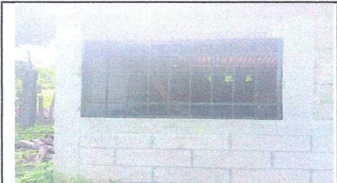
Foto 4: Sustitución de ventana de madera por balcon de metal .
