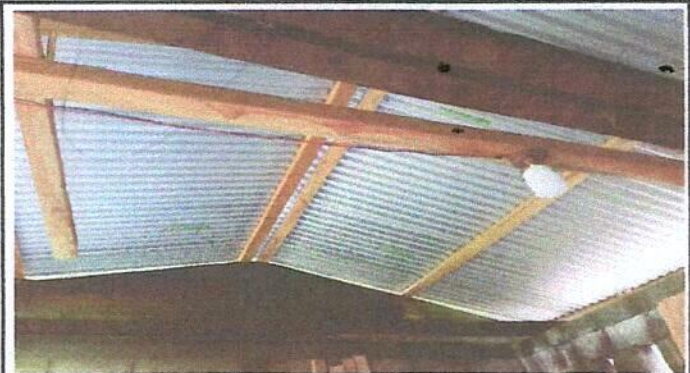
Foto 2: Sustitución de estructura de metal por madera
