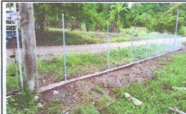
Foto 3: Sustitución de postes de madera por tubos galvanizados
