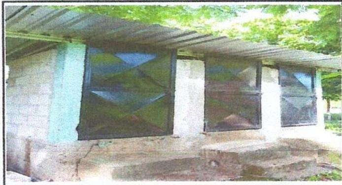
Foto 3: Sustitución de puertas de madera por metal.
