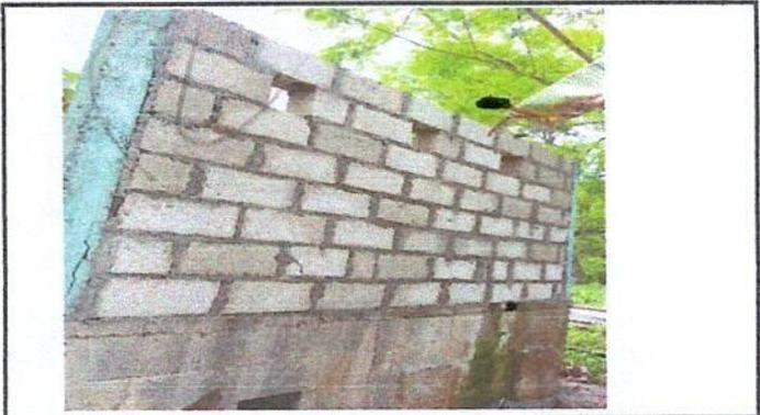
Foto 2: Sustitución de pared de madera por block
