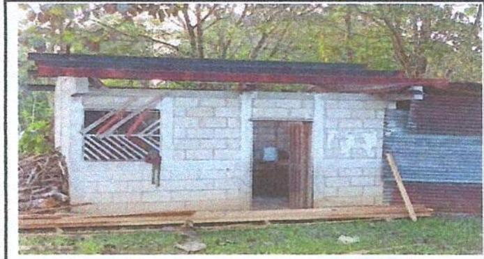
Foto 1: Sustitución de techo de la cocina
