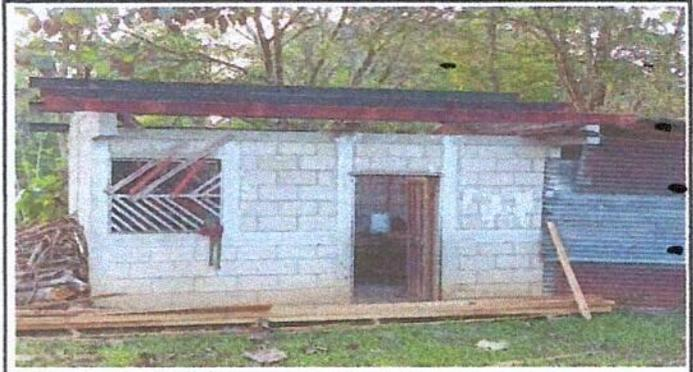
Foto 2: Sustitución de soporte de metal por madera
