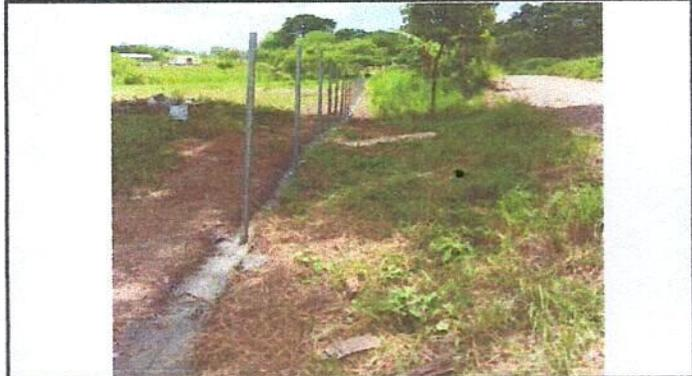
Foto 4: Sustitución de postes de madera por tubos galvanizados
