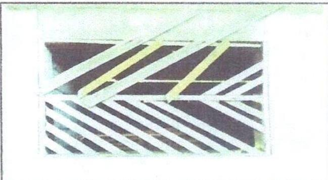
Foto 4: Sustitucion de ventana de madera por balcones de metal de la cocina escolar.
