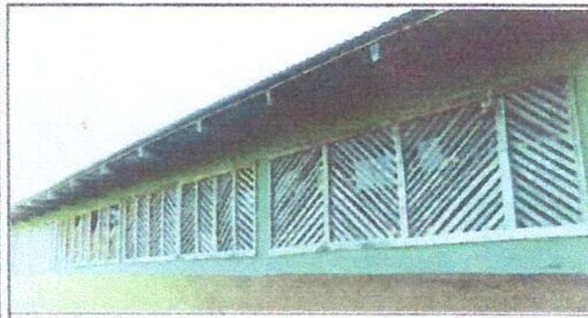
Foto 5: Sustitución de ventana de madera por balcones de metal del edificio escolar
