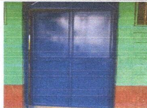
Foto 4: Sustrucción de puerta de metal
