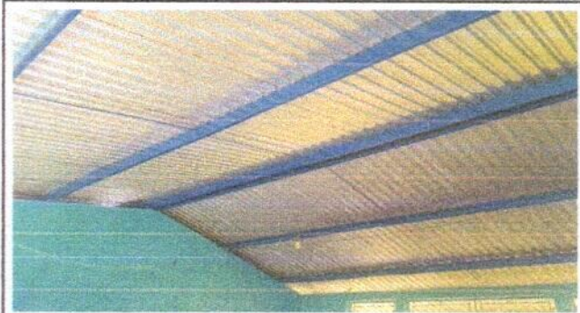
Foto 2: Sustrucción de capote
