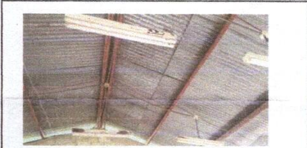
Foto 3: Mantenimiento de Estructura
