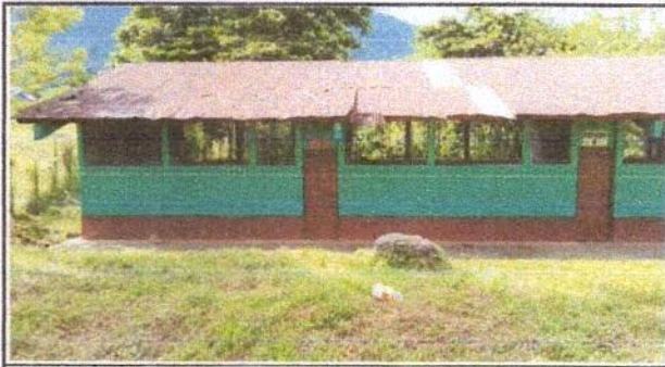
Foto 1 Sustitución de lamina, por lamina troquelada
