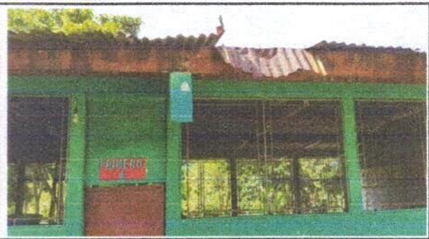
Foto 2: Sustitución de capote
