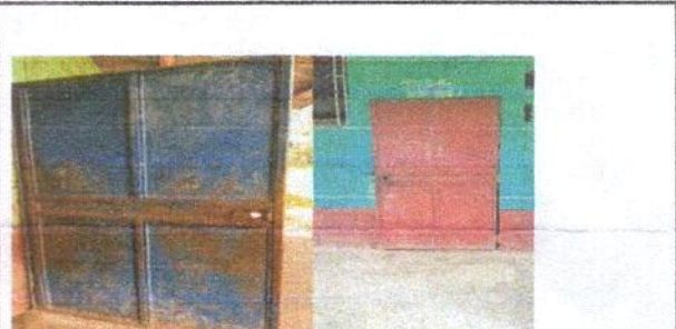
Foto 4: Sustitución de puertas de metal
