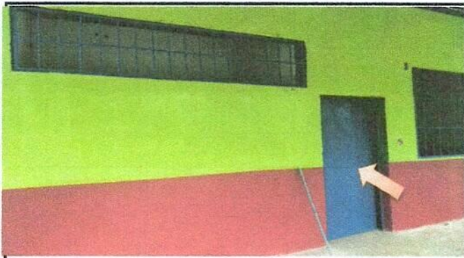
Foto 3: PUERTAS DE METAL. MANTENIMIENTO A ESTRUCTURA
