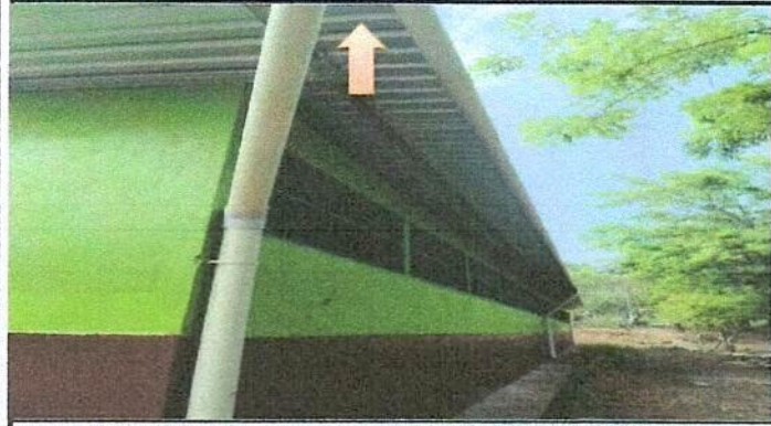
Foto 1. ESTRUCTURA DE TECHO. SUSTITUCION DE LAMINAS, POR LAMINAS TROQUELADA ALUZINC 26.
