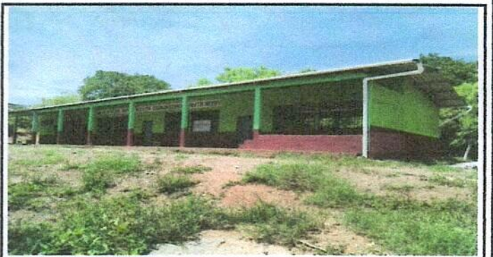
Foto 6: FIN DE REMOZAMIENTO
