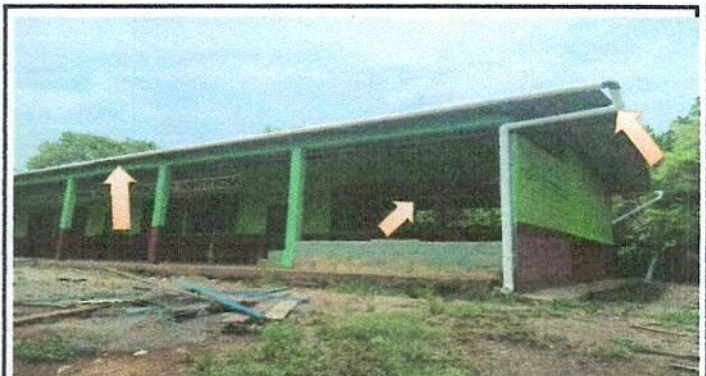
Foto 4: VENTANAS. CANALES Y BAJADAS DE AGUA PLUVIAL.
