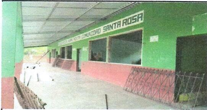
Foto 3: PUERTAS DE METAL. MANTENIMIENTO A ESTRUCTURA Y BALCONES
