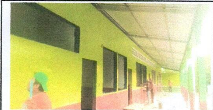
Foto 5: PINTURAS DE MUROS EXTERIORES E INTERIORES.
