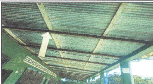
Foto 2: ESTRUCTURA DE TECHO. SUSTITUCION DE SOPORTE DE MADERA, POR METAL
