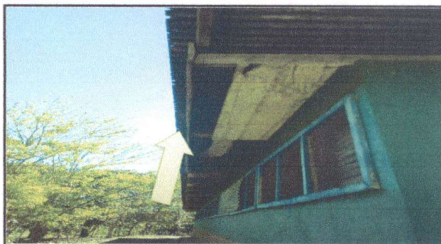
Foto 4: VENTANAS. CANALES Y BAJADAS DE AGUA PLUVIAL
