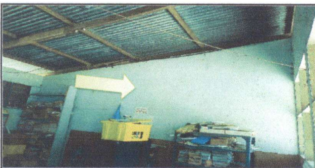
Foto 5: PINTURAS DE MUROS EXTERIORES E INTERIORES.
