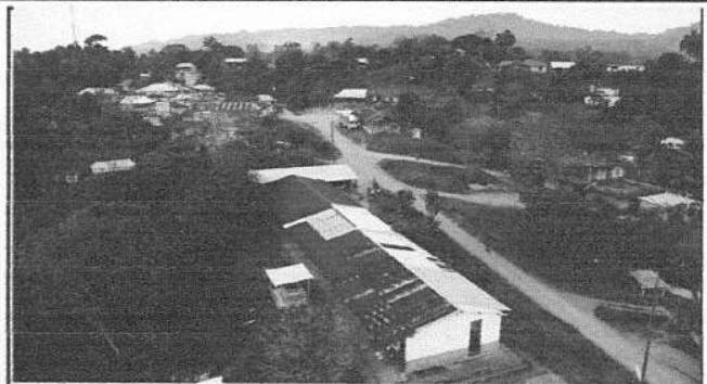
Foto 2: Sustitución de lámina por lámina troquelada aluzinc calibre 26 del centro educativo público
